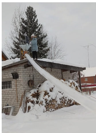
Рис. 11. Транспортирование с крыши
