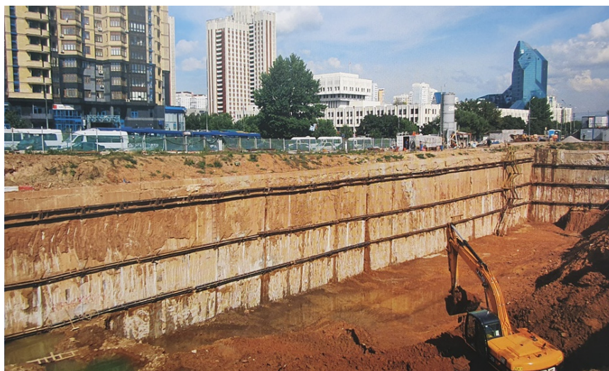
Рис. Устройство глубокого котлована в глинистых грунтах на объекте геотехнического строительства (по данным компании ООО «ИнжПроектСтрой») Fig. Excavation of a deep pit in clay soils at a geotechnical construction site (according to the company LLC «InzhPtroektStroy»)
