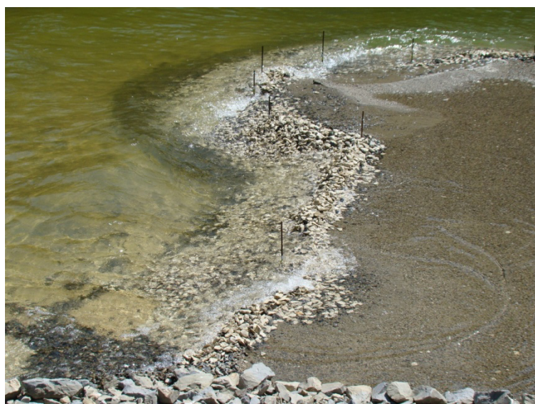
Рис. 4. Конструкция № 1. Деформации волногасящего откоса во время опыта Fig. 4. Construction No. 1. Deformation of the wave-damping slope during the experiment
