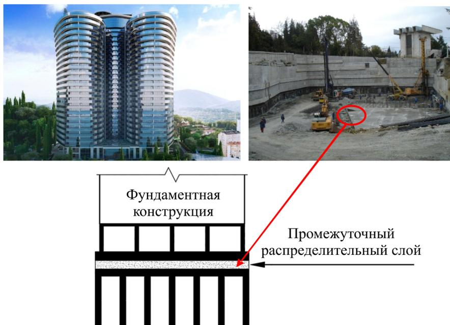
Рис. 11. Пример реализации методики расчета и конструирования фундаментов многоэтажных зданий по ул. Курортный пр-т, 108 в г. Сочи с применением промежуточного распределительного слоя
