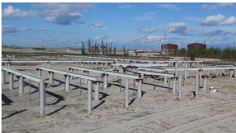
Рис. 11. Устройство свайного основания из бурозабивных свай под здание общежития вахтового жилого городка с применением проветриваемого подполья и СОУ
