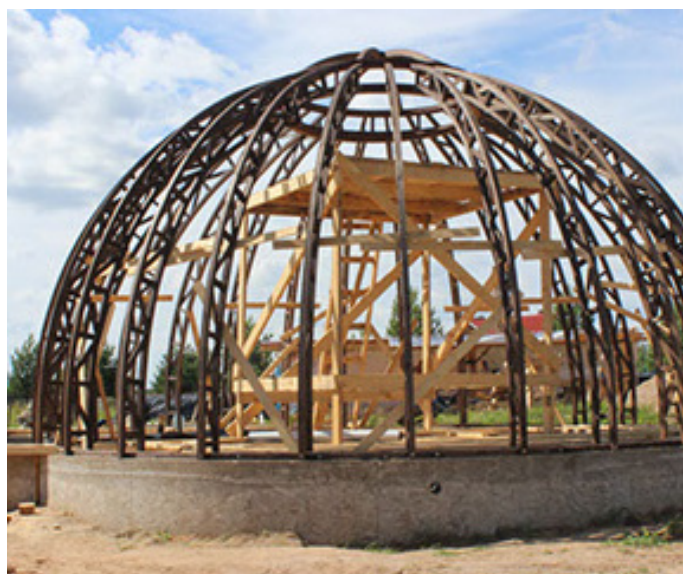
Рис. 3. Стратодезический купол Fig. 3. Stratodesic dome
