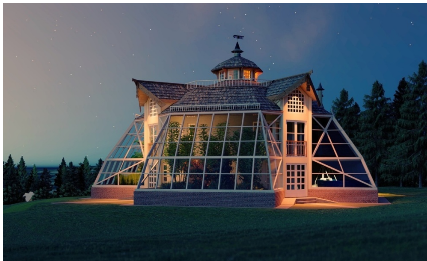
Рис. 6. Солнечный купольный дом с «двойной оболочкой» Fig. 6. Solar dome house with a “double shell”
