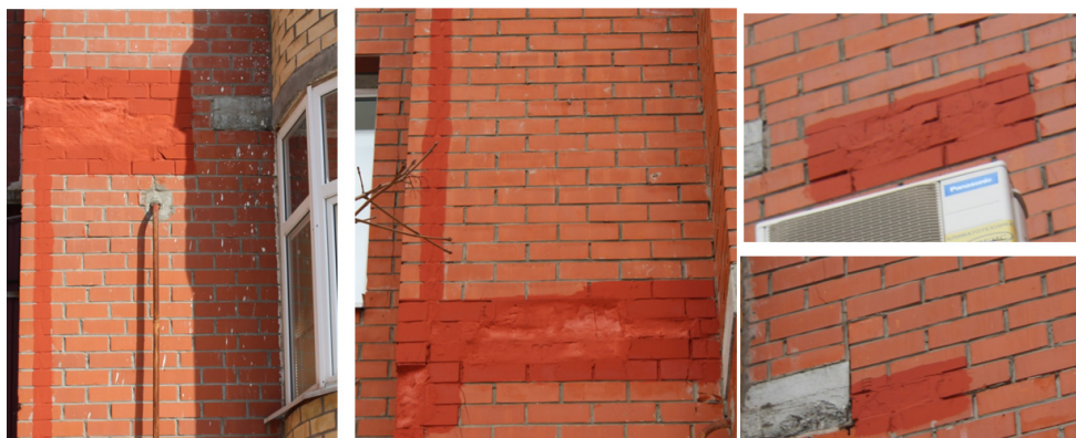
Рис. 3. Фрагменты наружных стен после устранения дефектов (2019 г.) Fig. 3. Fragments of the external walls after the elimination of defects (2019)
