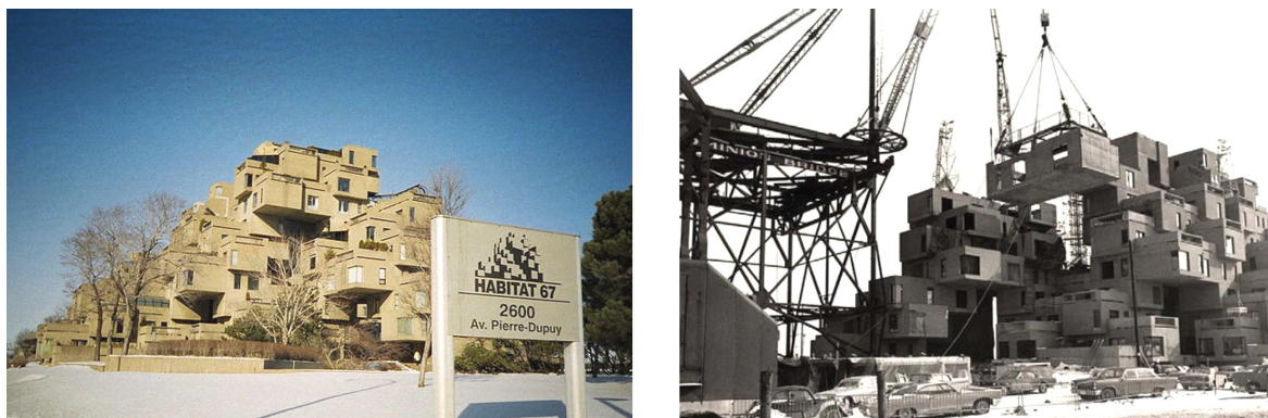
Рис. 1. Жилой комплекс «Хабитат 67» (Монреаль, Канада) [3] Fig. 1. Habitat 67 Residential Complex (Montreal, Canada) [3]
