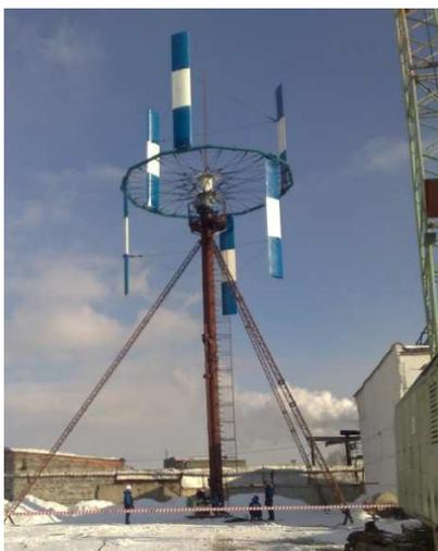
Рис. 4. Шестилопастная ВЭУ мощностью 30 кВт в составе ветродизельного комплекса общей мощностью 90 кВт
