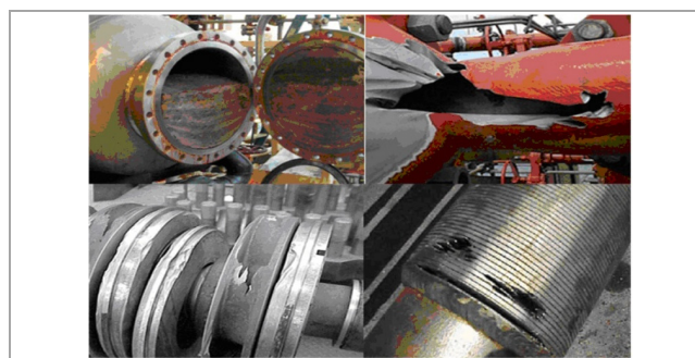
Рис. 4. Выведенное из строя оборудование вследствие пескопроявлений
